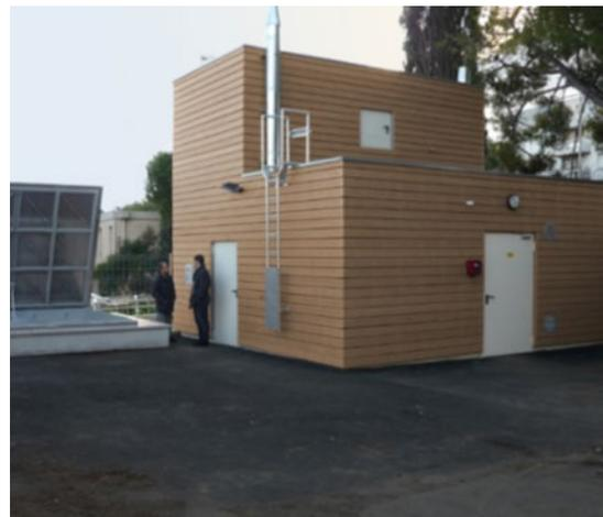
Abbildung 16: Holzheiz- und Lagerräume – Modulbauweise, Foto Quelle: Fa. Hargassner GmbH, Simbach/Inn, Heizmodul Lösungen
