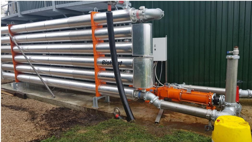
Abbildung 28: Außenliegender Wärmetauscher für Fermenter- oder Gärreste-Substrat
